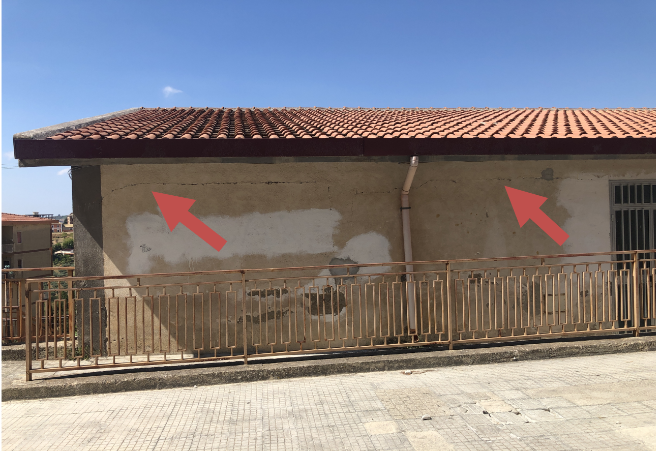
Foto 5 – Parete Prospetto EST
