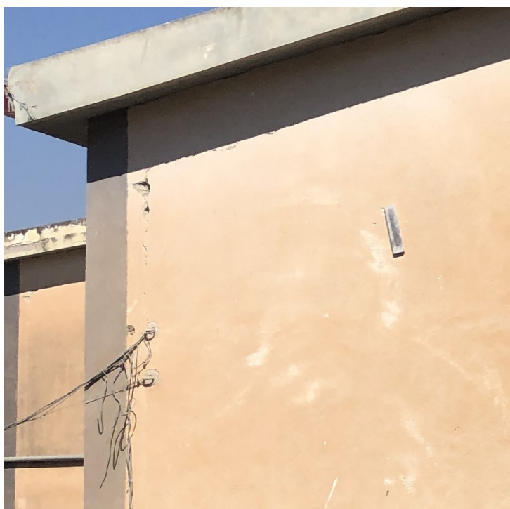
Foto 2 – Particolare Parete 1 Prospetto SUD
