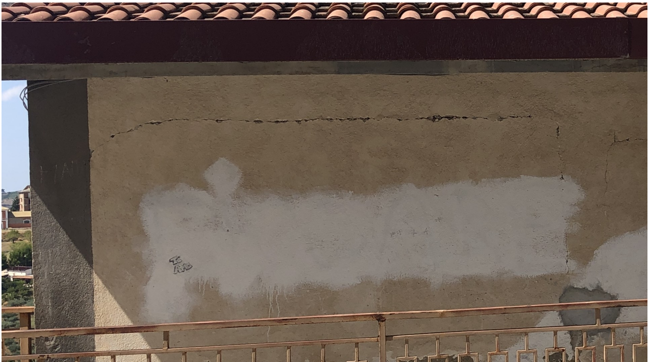
Foto 6 – Particolare Parete Prospetto EST
