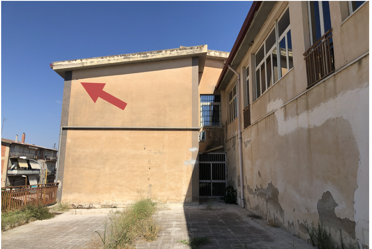
Foto 3 – Parete 2 Prospetto SUD
