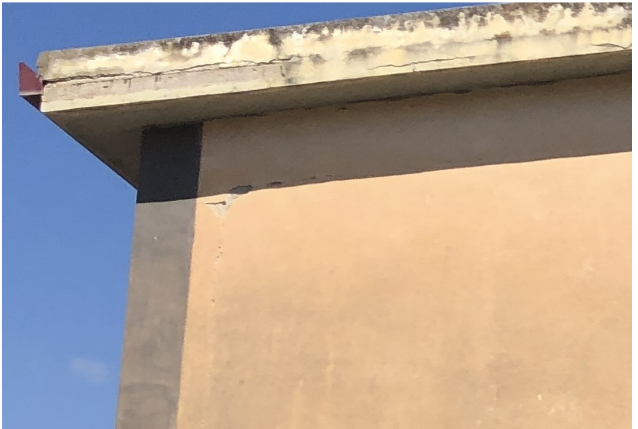
Foto 4 – Particolare Parete 2 Prospetto SUD
