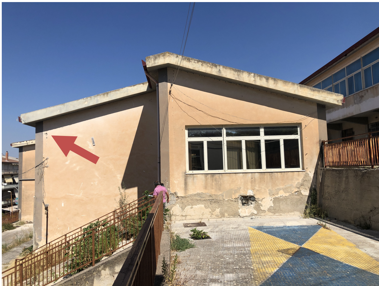
Foto 1 – Parete 1 Prospetto SUD
