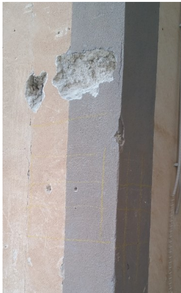
Foto 8 – Ft S6 Pac P10 - Pilastro A13
