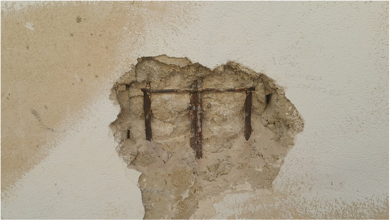
Foto 7 – Ft S3 Pac P12 - Pilastro B15
