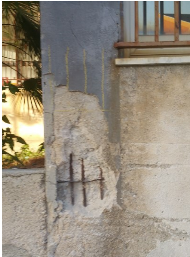
Foto 10 – Ft S8 Pac P11 - Pilastro A1
