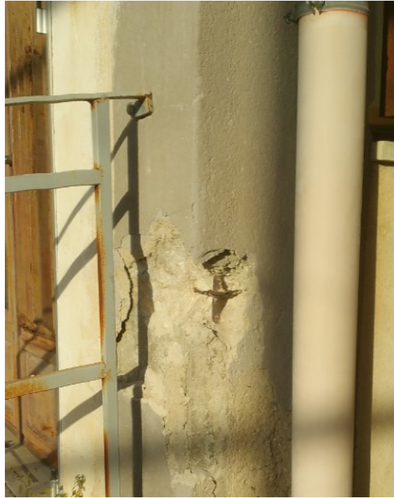
Foto 11 – Ft S9 Pac P15 - Pilastro A6
