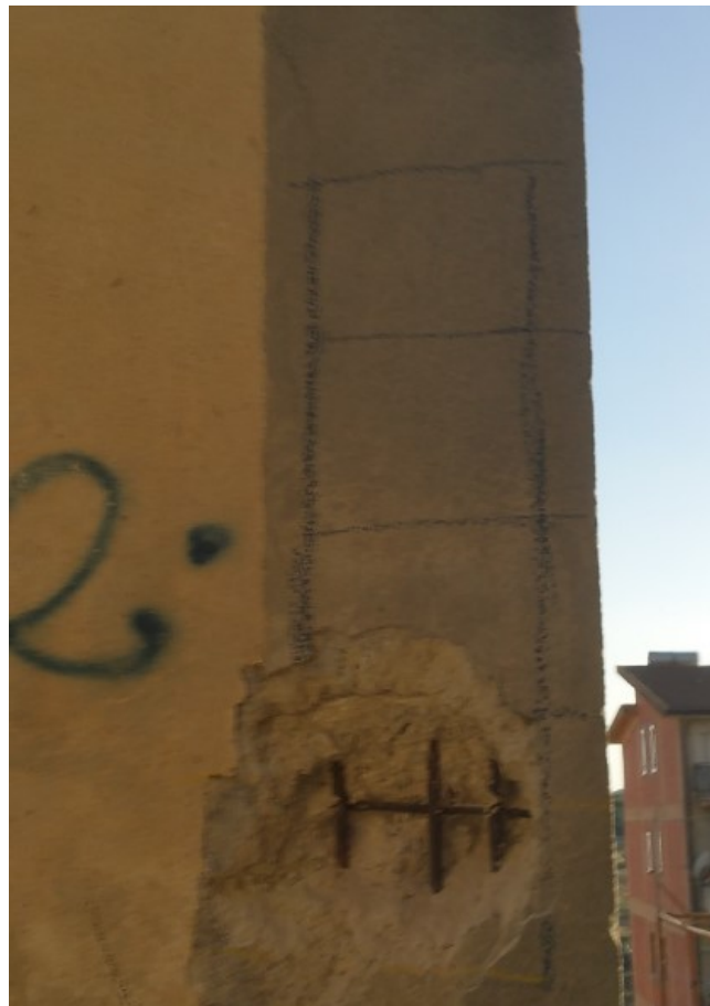
Foto 12 – Ft S10 Pac P1 - Pilastro A17
