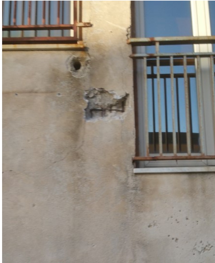
Foto 9 – Ft S7 Pac P5 - Pilastro A3
